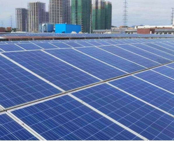
长园高能一期分布式光伏建设
